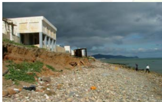
Figure 52 : Forte érosion du secteur côtier Habitation en péril
